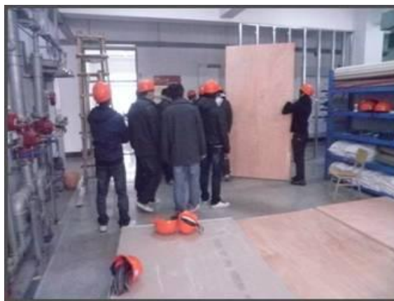
图 8：装饰施工实训室
